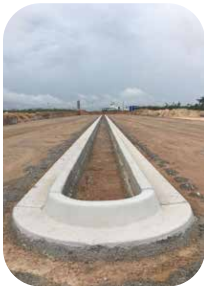
O bom confinamento (contenção) do piso executado, geralmente através de meio fio de concreto
