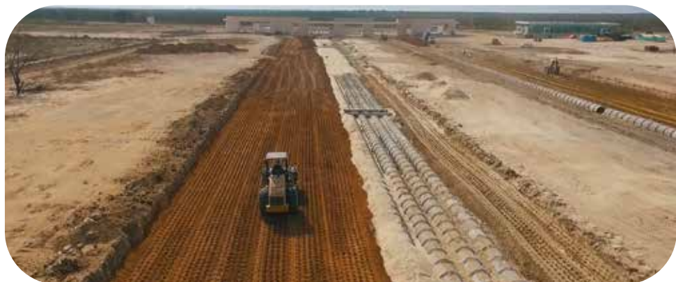
Processo de preparação do solo para aplicação de piso intertravado na Smart City Laguna
